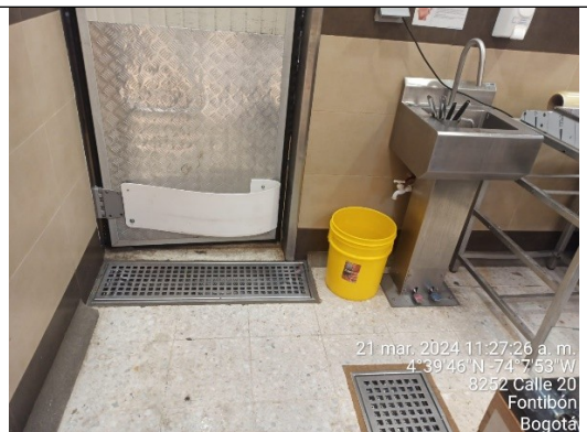
Foto No. 2. Rejillas zona preparación de alimentos
