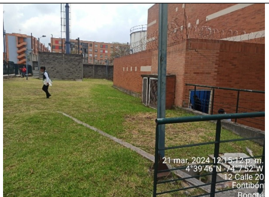
Foto No. 14. Ubicación PTAR y Caja de inspección interna
